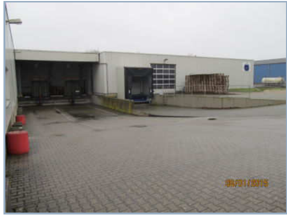
3 Laderampen mit Ladebrücken
